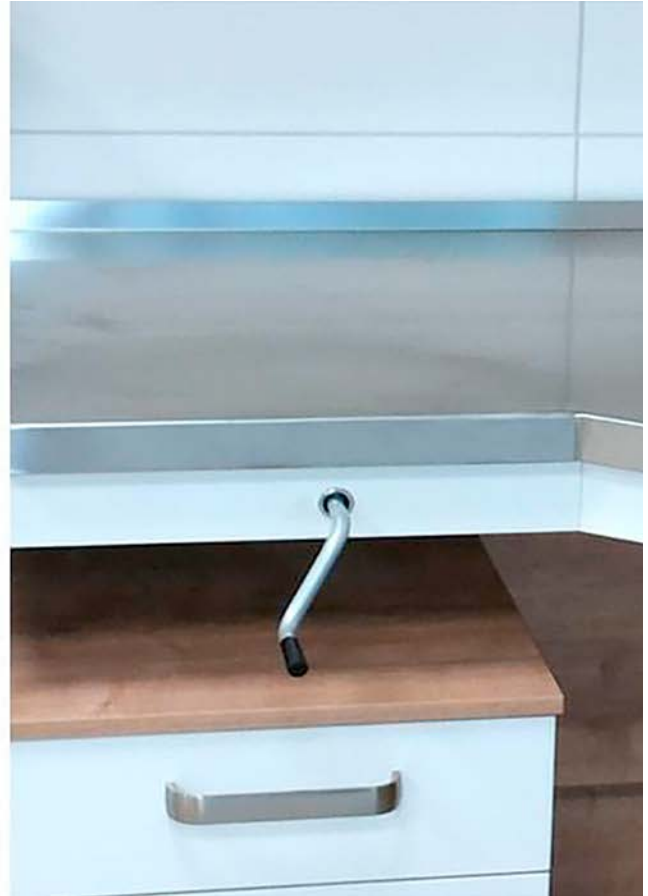
Höhenverstellbare Küchenelemente können im Sitzen oder Stehen und von Menschen unterschiedlicher Größe bequem genutzt werden.
