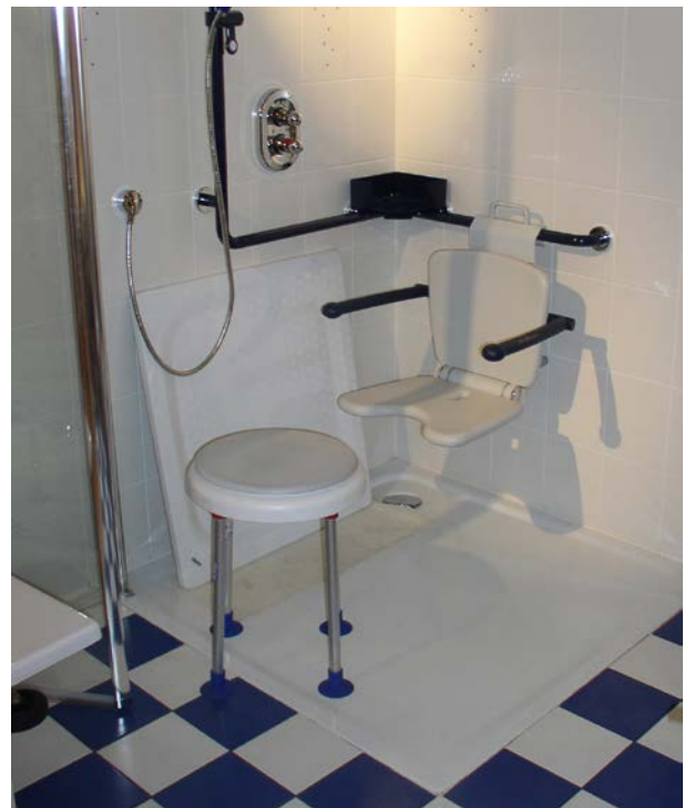
Eine bodengleiche Dusche sollte immer mit Haltegriffen ausgestattet werden.
