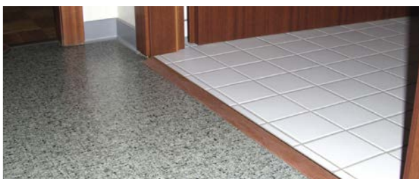
Niveauunterschiede können mit Schwellenkeilen ausgeglichen werden.
