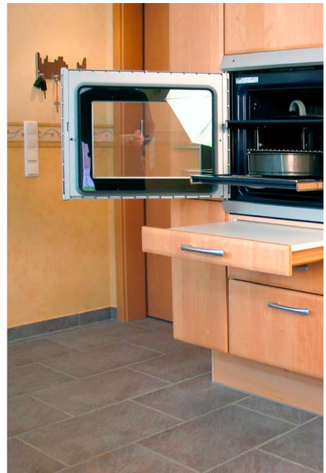
Ein Backofen auf Brusthöhe und eine darunter eingelassene ausziehbare Arbeitsplatte ermöglichen das Arbeiten im Stehen wie auch im Sitzen. Außerdem ist es praktisch, Heißes aus dem Ofen zu nehmen und direkt abstellen zu können.
