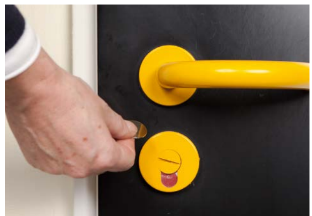
Ein von außen zu öffnendes Türschloss ist im Notfall wichtig.
