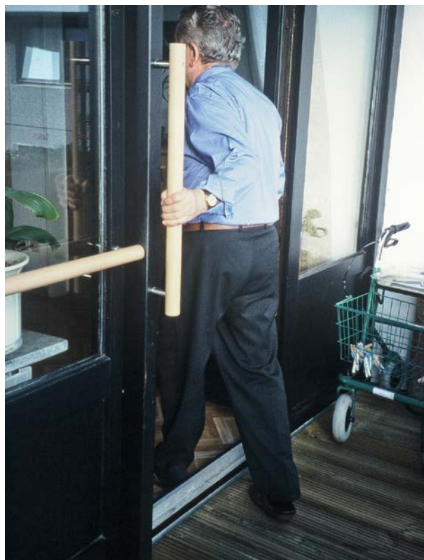
Die Stufe zum Balkon verschwindet durch das nachträgliche Anheben des Balkonfußbodens.
