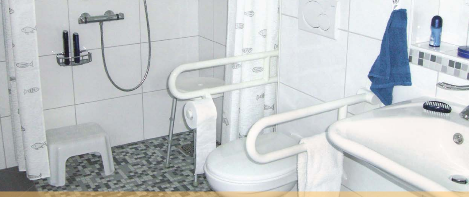
Seifenablage und Armatur der Dusche sollten in gut erreichbaren Höhen montiert werden.
