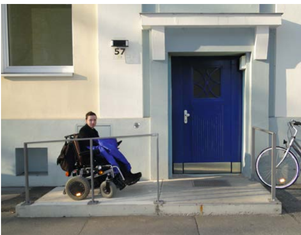
Eine flache Betonrampe ermöglicht die Benutzung des Eingangs auch für Menschen, die auf einen Rollstuhl oder Rollator angewiesen sind.
