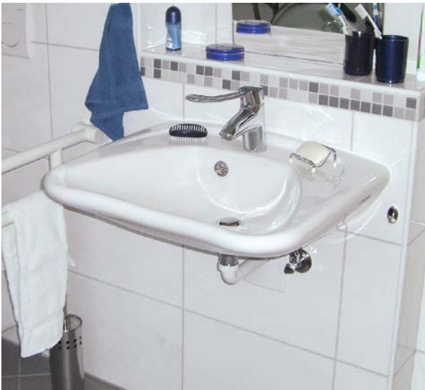
Ein Waschbecken mit Flachsiphon und tiefem Spiegel ist gut im Sitzen zu benutzen.
