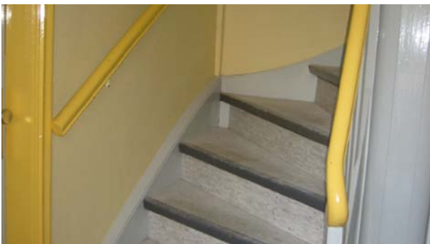
Eine Treppe sollte über zwei Handläufe und kontrastreiche Stufenkanten verfügen.
