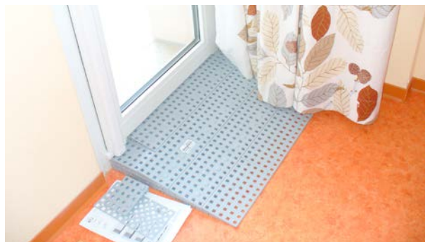
Eine (Kunststoff-)Rampe kann innen und außen individuell angepasst werden.
