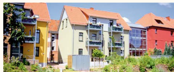
Celler Bau- und Sparverein eG, Gebäude des Wohnprojekts „WoGe Celle“
